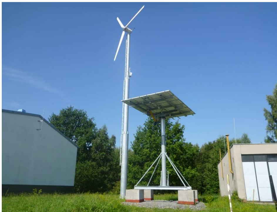
obr. 2 Fotografie větrné elektrárny společně s polohovací natáčeací jednotkou fotovoltaické elektrárny.
